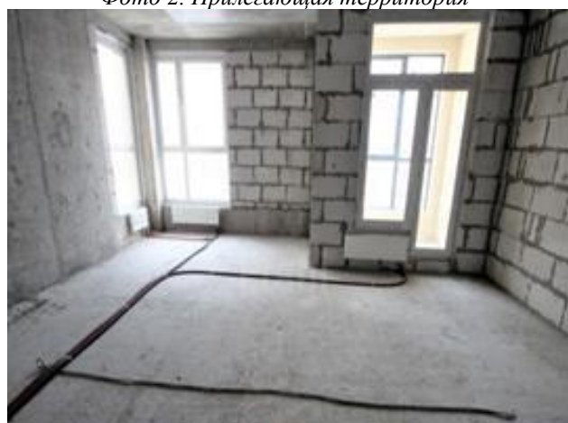
Фото 4. Состояние внутренней отделки квартир
