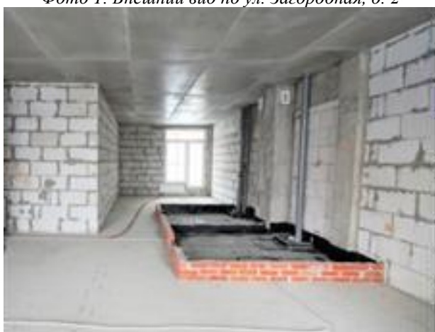
Фото 3. Состояние внутренней отделки квартир
